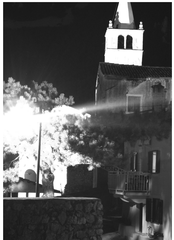
Sl i k a 7 – Primjer loše javne rasvjete snimljen u Plominu
