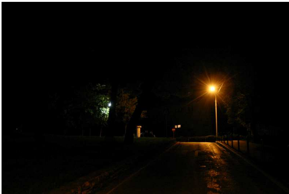
Slika 23. Uspon na Monte Zaro (Boškovićev uspon) - primjer loše postavljene neekološke rasvjete koja zasljepljuje vozače
