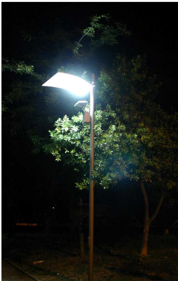
Slika 25. Park Monte Zaro - primjer „polu-ekološke“ rasvjete koja je ujedno i loše postavljena (previše svjetlosti odlazi pored reflektora)
