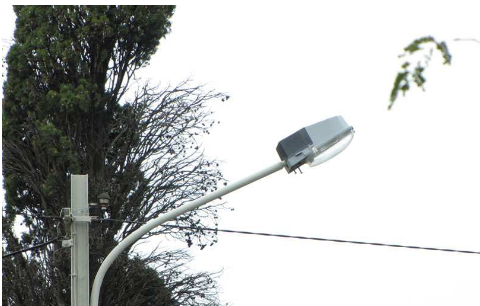
Slika 24. Uspon na Monte Zaro (Boškovićev uspon) - primjer loše postavljene neekološke rasvjete koja zasljepljuje vozače
