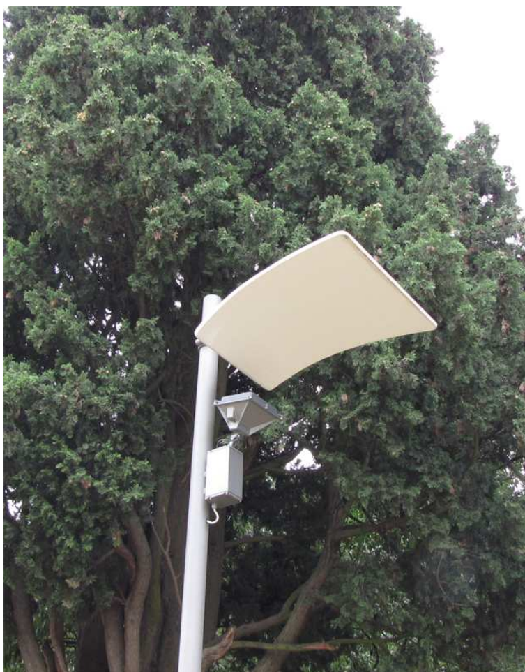
Slika 26. Park Monte Zaro - primjer „polu-ekološke“ rasvjete koja je ujedno i loše postavljena (previše svjetlosti odlazi pored reflektora)
